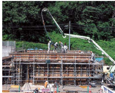
① 新築工事（小水力発電所）
